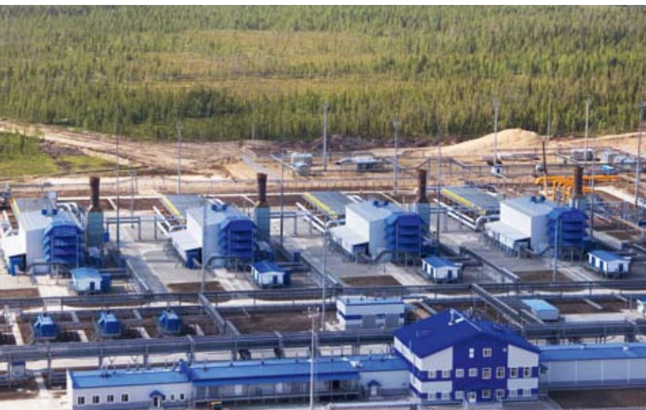
ГПА-32 «Ладога» на КС «Чикшинская» МГ Бованенково — Ухта
