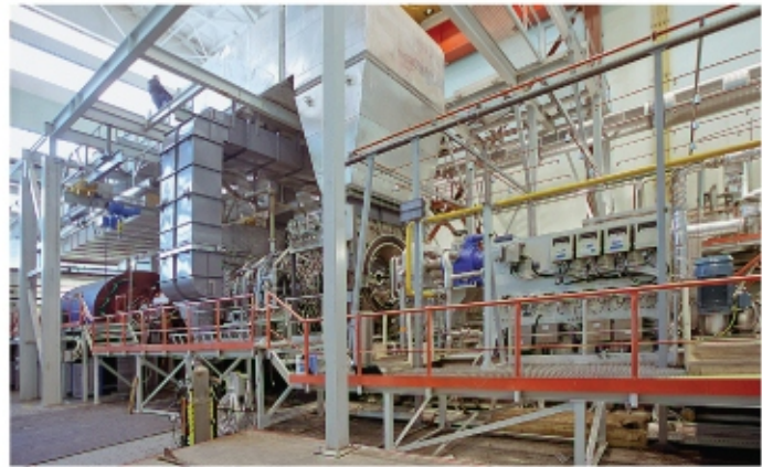
Фото 2. Испытательный стенд ГПА-32 «Ладoga» на Невском заводе
